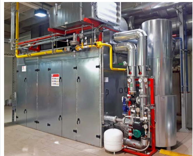
Das BHKW im Heizkraftwerk Gorndorf
