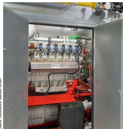
Die Schaltanlage im Heizkraftwerk Gorndorf
