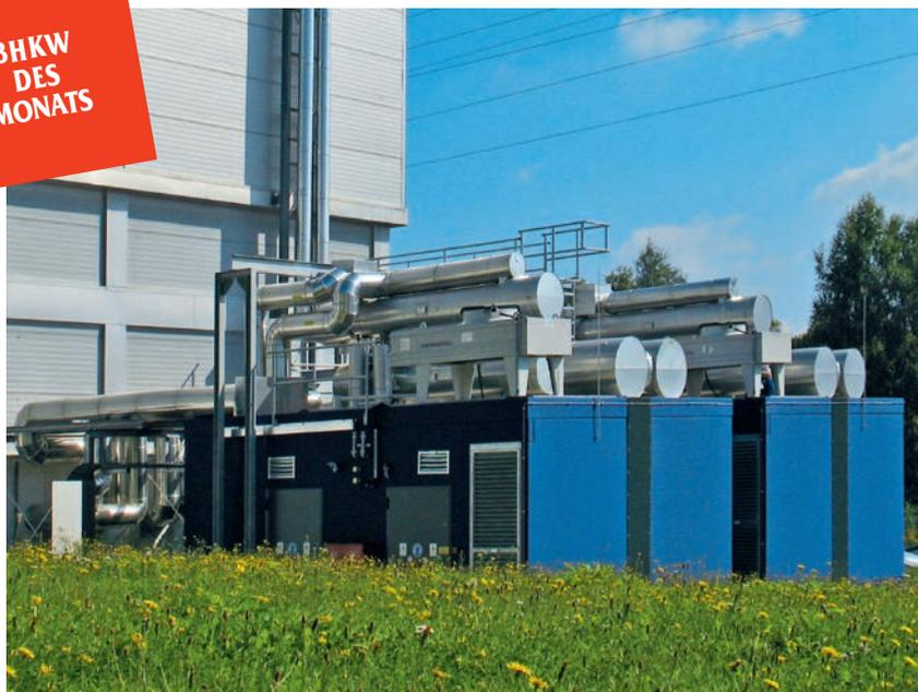
Im Rackwitz Werk vormontiert, in Freiberg schallgeschützt aufgestellt: zwei 600-kW-BHKW-Module in vier Betonzellen
