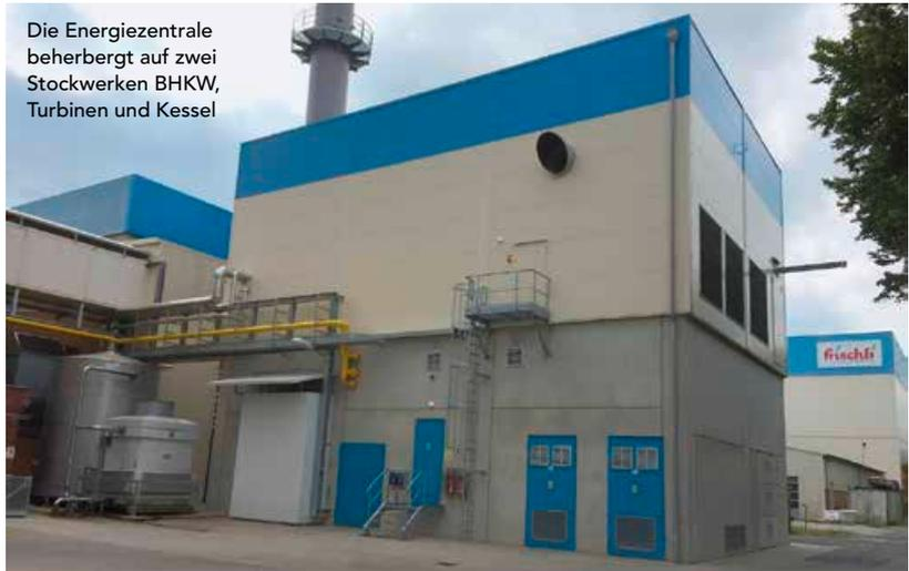
zept ist eine Mikrogasturbinenanlage mit Abhitzekessel. Die Gasturbinen von Capstone stellen eine elektrische Leistung von 800 kW bereit und produzieren über den Abhitzekessel mit Zusatzfeuer bis zu 10 t Dampf pro Stunde. Es gibt zwar keinen Wärmespeicher wie beim BHKW, aber die elektrische Leistung der Turbinen kann dennoch unabhängig von der gerade benötigten Dampfleistung geregelt werden; damit lässt sich auch hier die elektrische Leistung flexibel nutzen.
