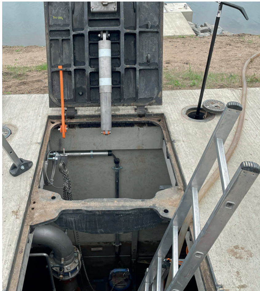
Bild 1. Im Bereich der Stepenitz wurde ein Entnahmebauwerk einschließlich Pumpenschacht errichtet
